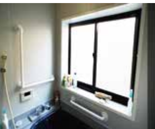
浴室到手摺設置
