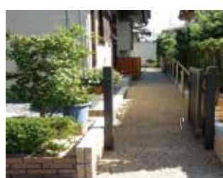
勝手口通路にスロープと手摺設置
