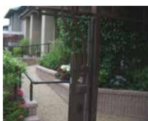
アプローチにスロープと手摺設置
