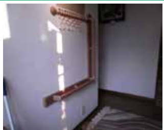
玄関ホール到手摺設置
