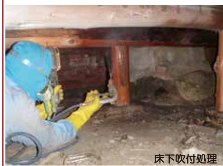
床下吹付処理
