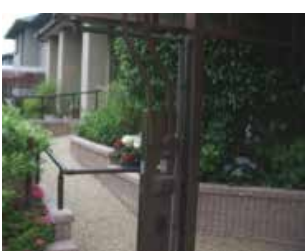
アプローチにスロープと手摺設置
