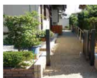
勝手口通路にスロープと手摺設置
