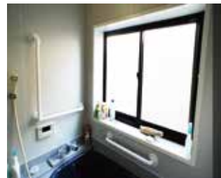
浴室に手摺設置
