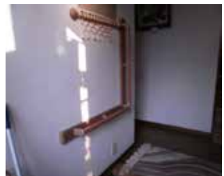
玄関ホールに手摺設置
