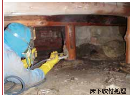
床下吹付処理
